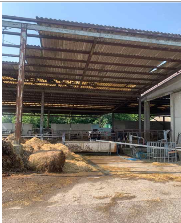
Parte di tettoia esterna
