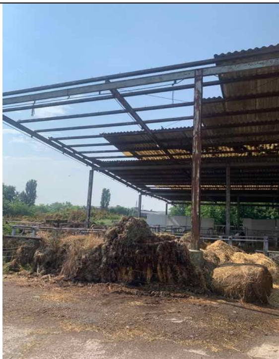
Parte di tettoia esterna
